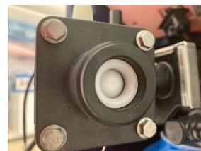
Flangia di raccordo della testa dell'addolcitore (IN/OUT)
