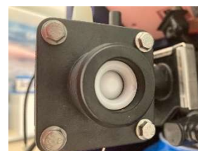
Bride de raccordement de la tête de l'adoucisseur (ENTRÉE/SORTIE)
